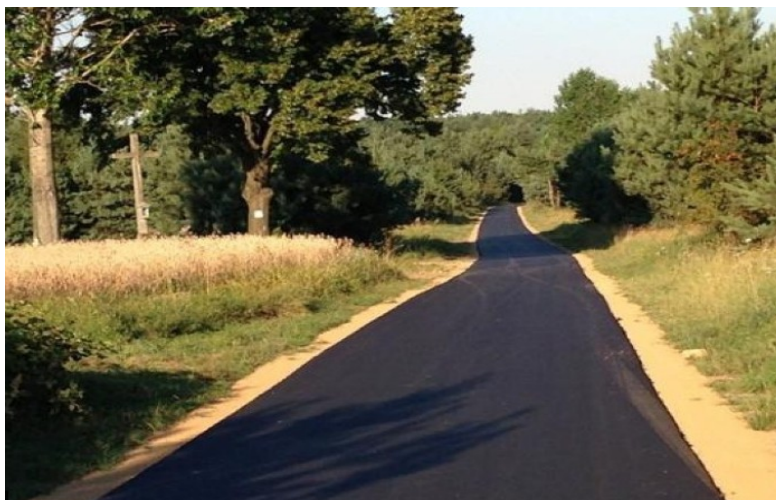
Ilustracja 37: Wykonanie drogi wewnętrznej o nawierzchni bitumicznej na terenie leśnym.
